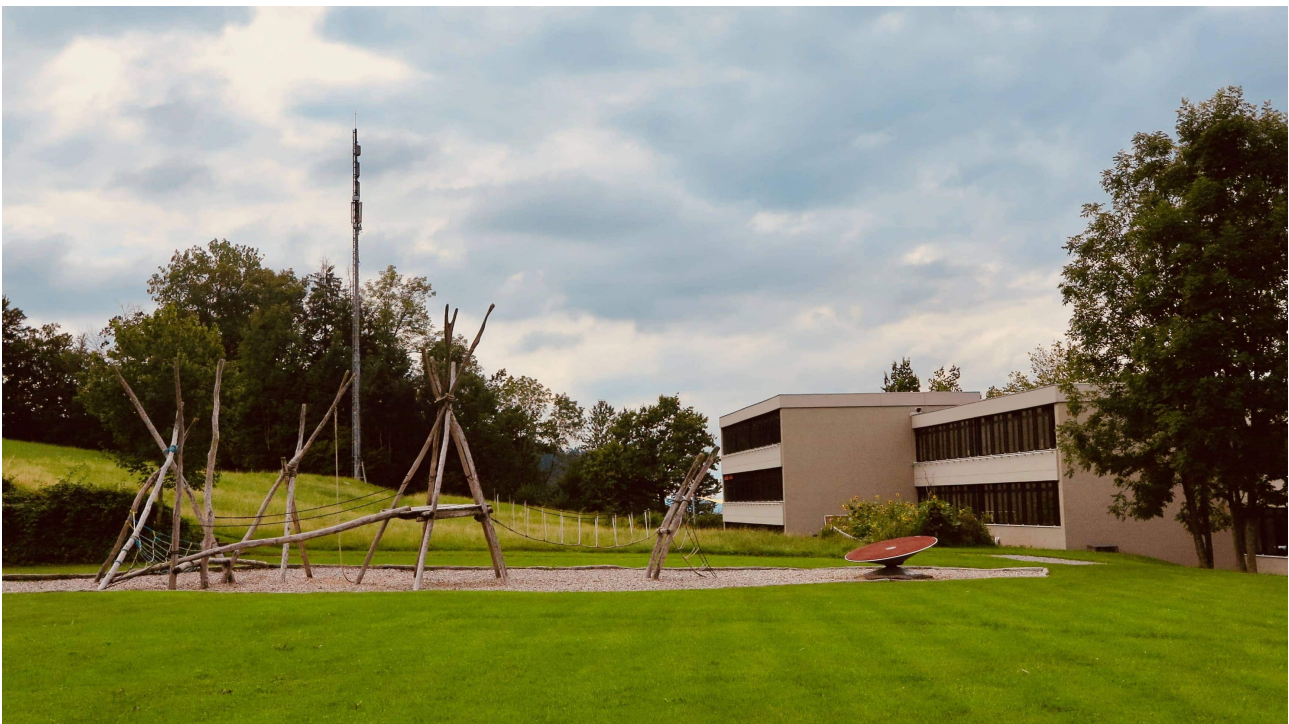
Mobilfunkantenne beim Schulhaus Neuwies in Wald ZH.
